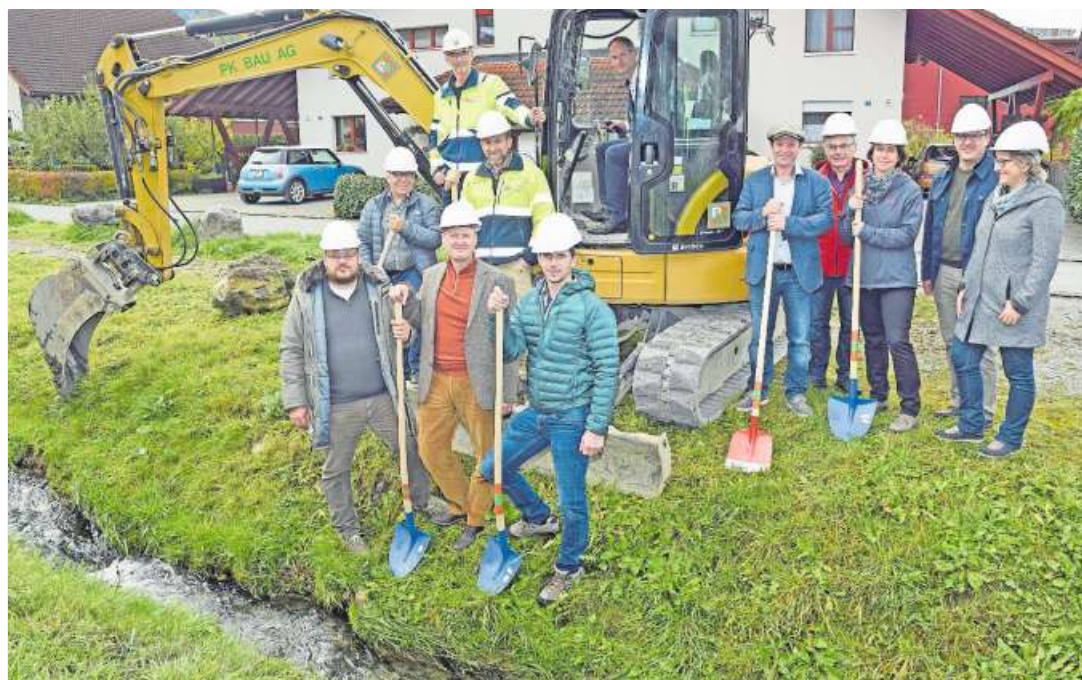
Spatenstich für die Realisierung des Hochwasserschutzprojektes Sandbach. Anwesend waren unter anderen Anwohner und Vertreter der kommunalen und kantonalen Behörden. Bild: Robert Hess (6. November 2018)
